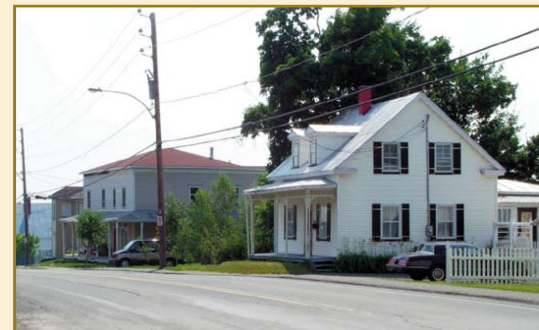
RUE PRINCIPALE – WICKHAM
